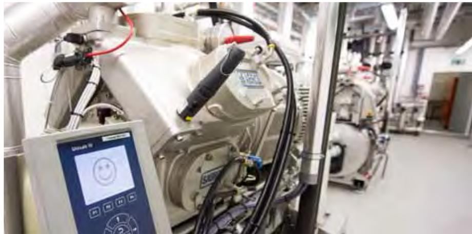
Im Kantonsspital Glarus wird die erforderliche Wärmeenergie für die Gebäudeheizung sowie die Warmwassererwärmung neu mit umweltneutraler Energie aus dem Grundwasser gewonnen und gleichzeitig wird die Kälteproduktion für die medizinischen Einrichtungen sichergestellt.
